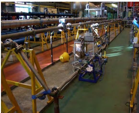
Figure 4 TUV NEL 1 st water installation
